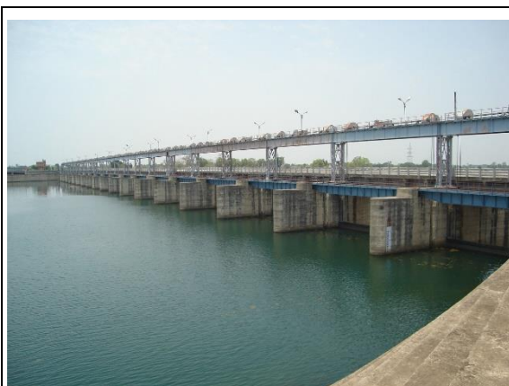
(E) Rudri Barrage
